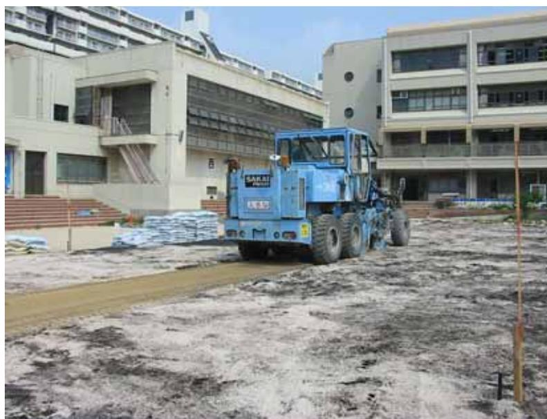
床土整備 大型重機（スタビライザー）による混合作業
